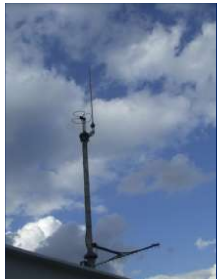
NO mast toegevoegd nieuw mastdeel met RX antenne PI2HLM op uithouder
