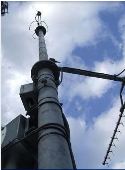
Oud onderdeel en nieuw bovendeeel NO mast
