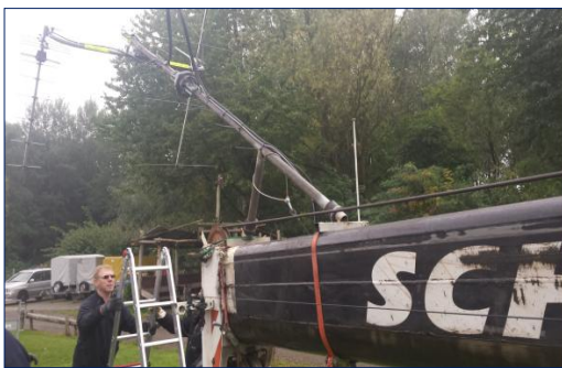
De montage van de antennes op de kop van de kraan
